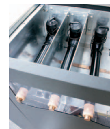
Sammelschienenraum
